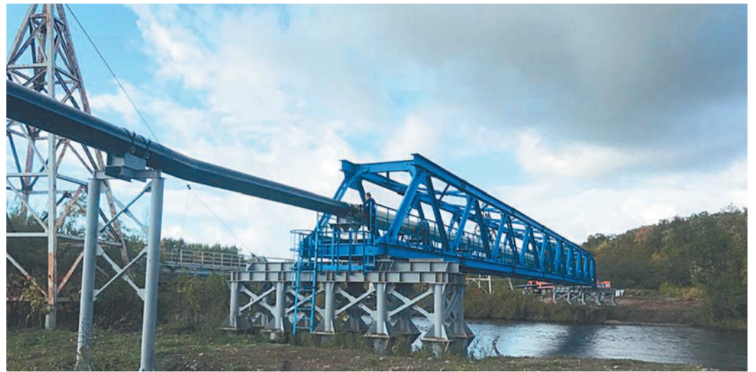
В прошлом году специалисты УАВР впервые провели капитальный ремонт надводных переходов на Камчатке
